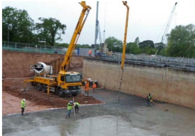
**Fig. 2: Concrete pour over the Deckdrain**
